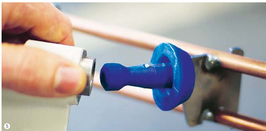
Figura 5: Lo speciale GHA, sistema di mascheratura e appensione.
